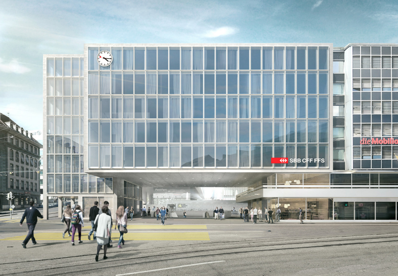
Neubau Bubenbergzentrum Bern, Ausführung 2022 – 2024
